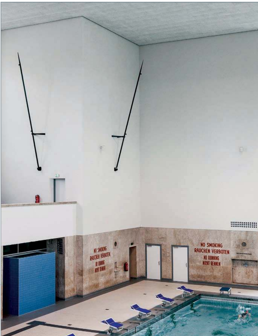
■ Erneuerung des Edelkratzputzes mit Marmorzuschlag; Foto: Ina Schoenenburg für Heradesign, Ferndorf (Österreich) / ofischer communication, Bonn
