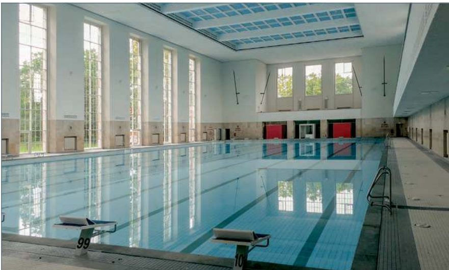
■ Sanierter Zustand: Wiedergewinnung der Fensterteilung und der Deckenanmutung; Foto: Tobias Reckert, Berlin
