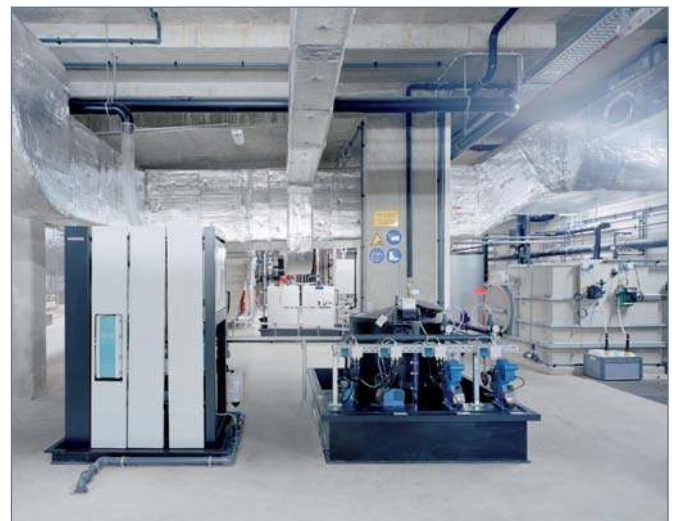
■ Die Technik im Untergeschoss
