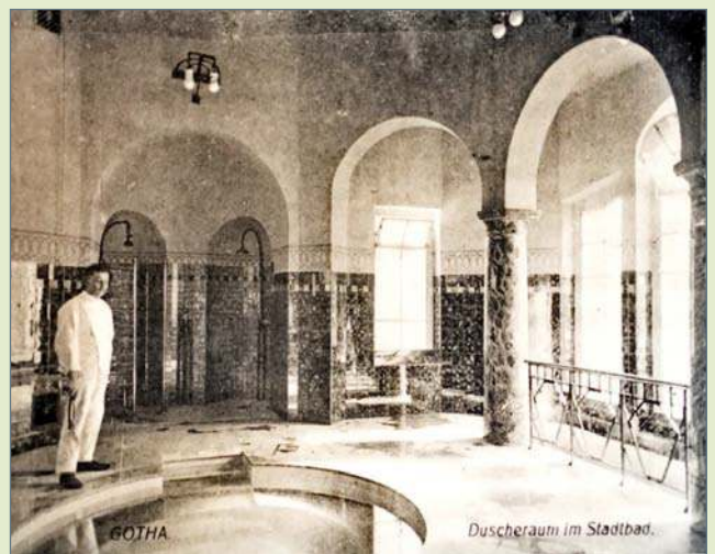
■ Alte Sauna, Kuppelraum
