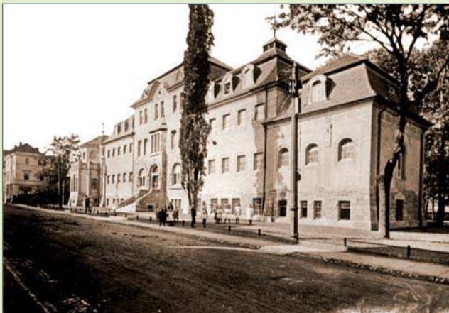
■ Altes Stadtbad (alle 1909); Fotos: Denkmalamt, Gotha
